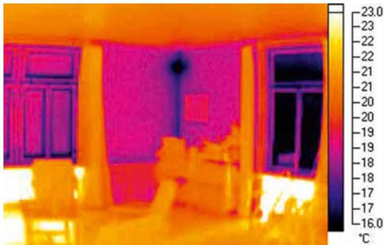
Innenaufnahme: Links ein gutes Doppelglas mit WSS, rechts ein altes Doppelglas ohne WSS, welches viel kälter wird.
