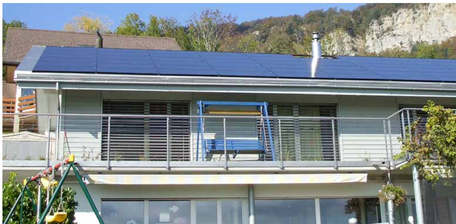
Dach mit Solarmodulen von Megasol: Erneuerbare Energien schaffen Arbeitsplätze in der Region.
