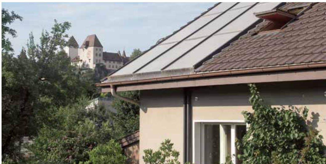
Einfamilienhaus mit Anlage für Warmwasser und Heizungsunterstützung: In neun Jahren wurden rund 20 Tonnen CO 2 bzw. 8000 Franken eingespart.
