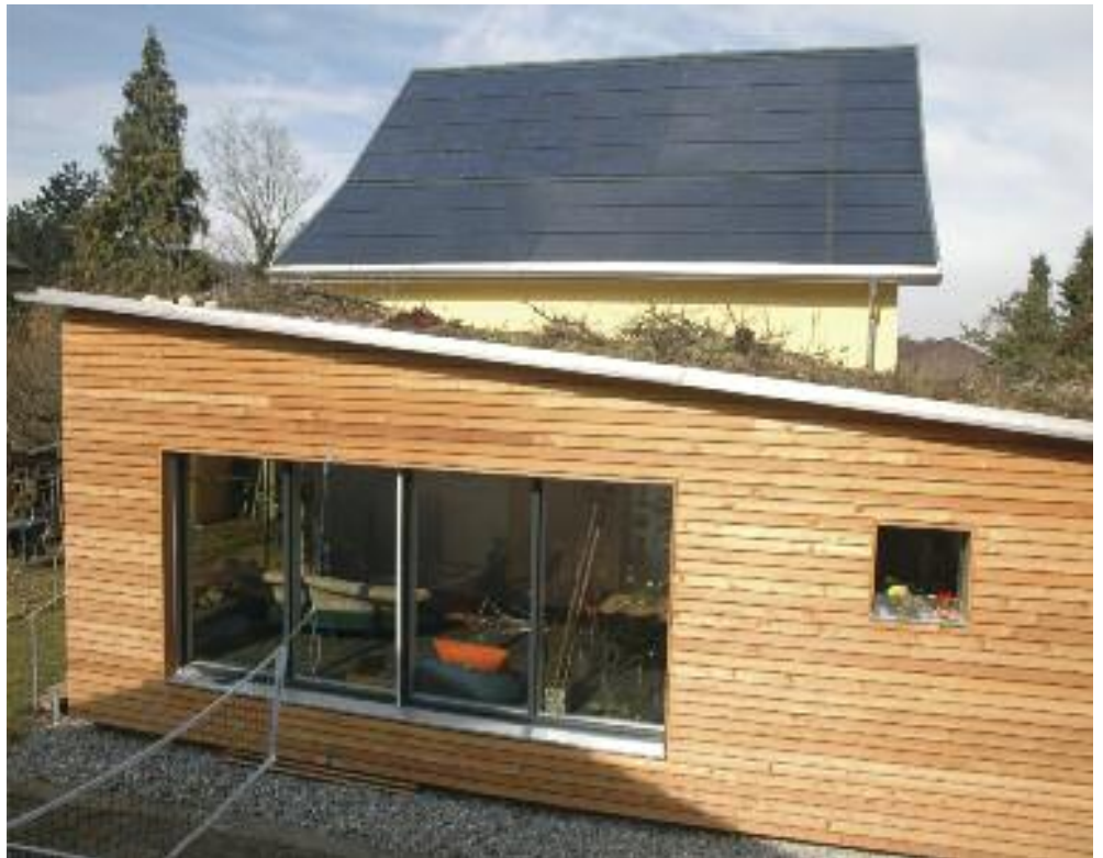
Vorbildlich sanierte Liegenschaft: Photovoltaikanlage und Anbau mit Naturdach
